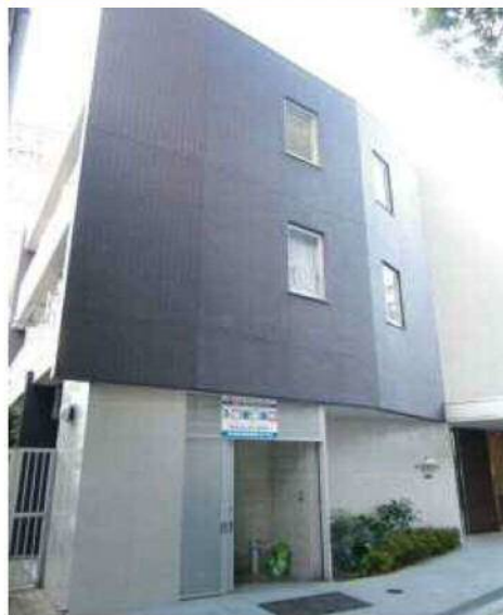
グランドール東園田 外観
