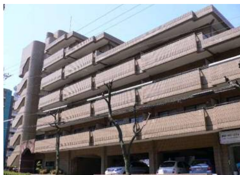
グリーンロータス I 外観
